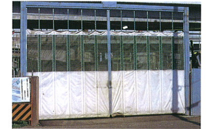
CE 密閉型 防音シート貼り
